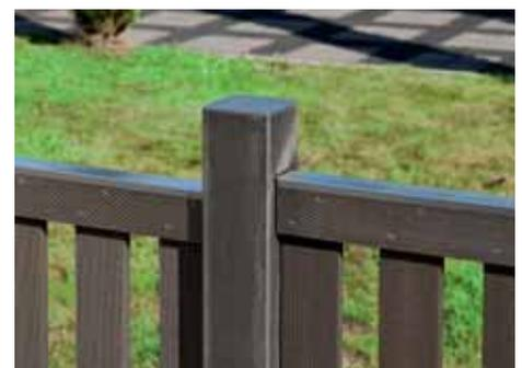
Die Alu-Aufsatzleiste schützt das WPC vor Verzug und Staunässe (mit MS Polymer-Kleber befestigen).
